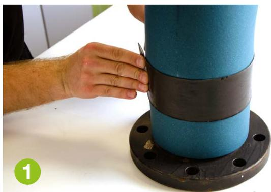
Se il diametro della curva è  $>90$  mm, è possibile applicare il metodo di avvolgimento. Utilizzare il nostro prodotto Arma-Chek Wrap con una larghezza di 70 mm e iniziare il processo di avvolgimento da un'estremità della curva e procedere verso l'altra estremità.
