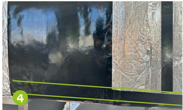
Le parti sinistra e destra del condotto isolato e quella superiore possono essere coperte con Arma-Chek Wrap in unico foglio. Nella parte inferiore deve essere predisposto un sormonto di almeno 20mm.
