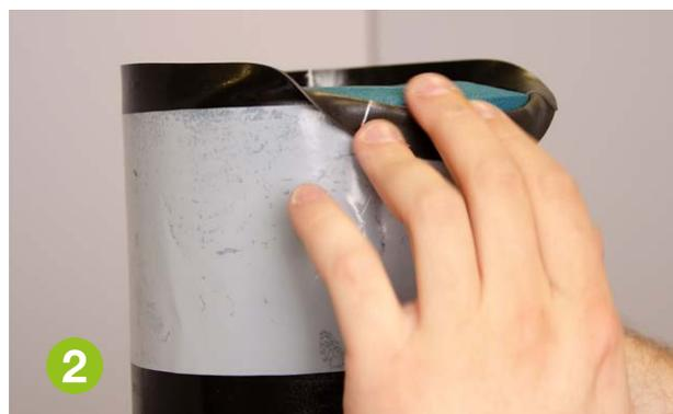
**2** Ripiegare l'eccesso longitudinale di 20 mm. Per evitare che la sezione piegata si attacchi a se stessa, è essenziale inserire uno strato di carta intermedio tra il pezzo piegato e la superficie del prodotto Arma-Chek Wrap.
