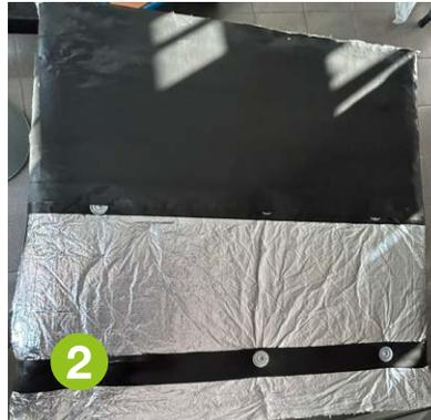
Tagliare Arma-Chek Wrap in una lunghezza pari alla larghezza del condotto isolato + 20 mm in più da entrambe le estremità per la sovrapposizione e applicare sulla sezione inferiore del condotto.
