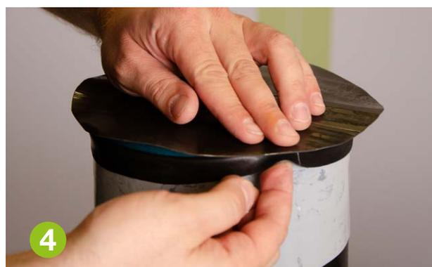
**4** Applicare il disco all'estremità del tubo e dispiegare il primo rivestimento applicato. Durante il processo di vulcanizzazione, è importante far coincidere i bordi del tappo terminale e del rivestimento del tubo.
