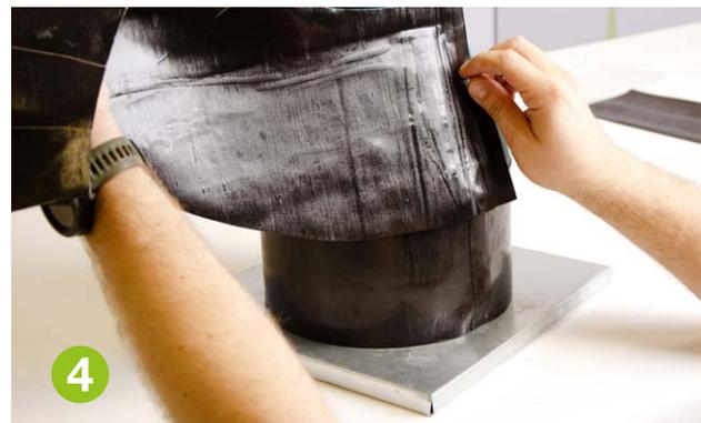
Partendo da un'estremità del riduttore, avvolgere con cura il materiale autosaldante intorno al tubo. Assicurarsi che il materiale sia ben fissato senza spazi vuoti.
