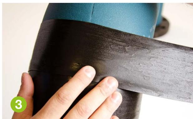
Applicare una tensione moderata al materiale di rivestimento autosaldante mentre lo si avvolge intorno al tubo. Ciò contribuisce a garantire un'applicazione sicura e uniforme.
