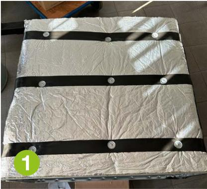
Applicare fasce di Arma-Chek Wrap da 70mm su tutto il perimetro del condotto coibentato con distanze di 300 mm. Adatto per applicazioni con perno secondo DIN4140. Sezione
