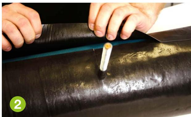
Procedere come per il rivestimento di un tubo diritto. Prevedere un'apertura di diametro pari al diametro del tondino.
