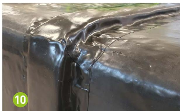
Procedere come nel passaggio precedente e applicare Arma-Chek Wrap attorno a tutta la flangia. Prestare molta attenzione che non sia visibile alcun materiale isolante e che l'applicazione sia a tenuta stagna.
