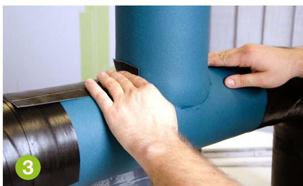
Posizionare Arma-Chek Wrap e fissarlo alla superficie isolante.
