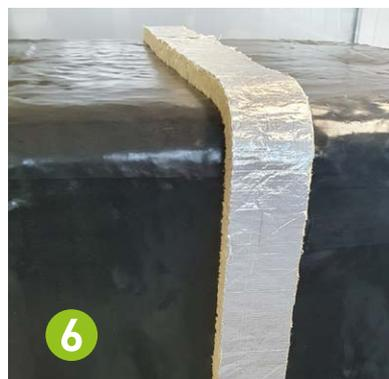
Per isolare efficacemente le flange dei condotti, utilizzare Arma-Chek Wrap e misurare la circonferenza della flangia. Garantire una sovrapposizione minima di 20 mm per un corretto isolamento.
