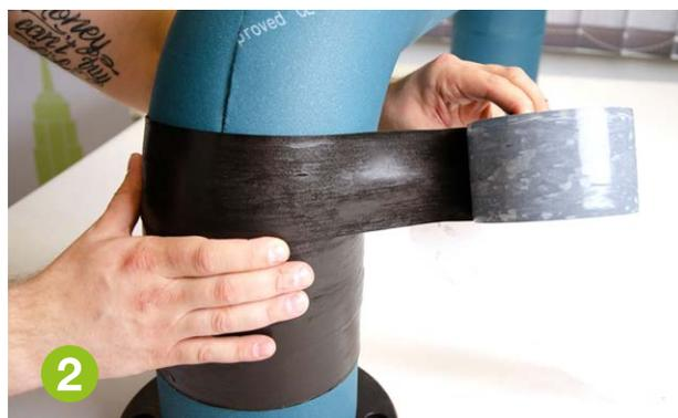
Avvolgere il materiale di rivestimento autosaldante intorno al tubo isolato, assicurandosi che ogni nuovo strato si sovrapponga al precedente per almeno 20 mm.
