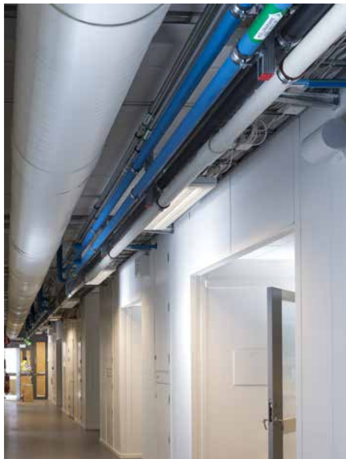
Armaflex Ultima jest umieszczony w wykazie bezpiecznych materiałów Byggarubedömningen (BVB), Szwedzkiego instytutu oceniającego wpływ na środowisko materiałów budowlanych - ważnego kryterium na tym wymagającym projekcie realizowanym zgodnie z zasadami zrównoważonego budownictwa.
