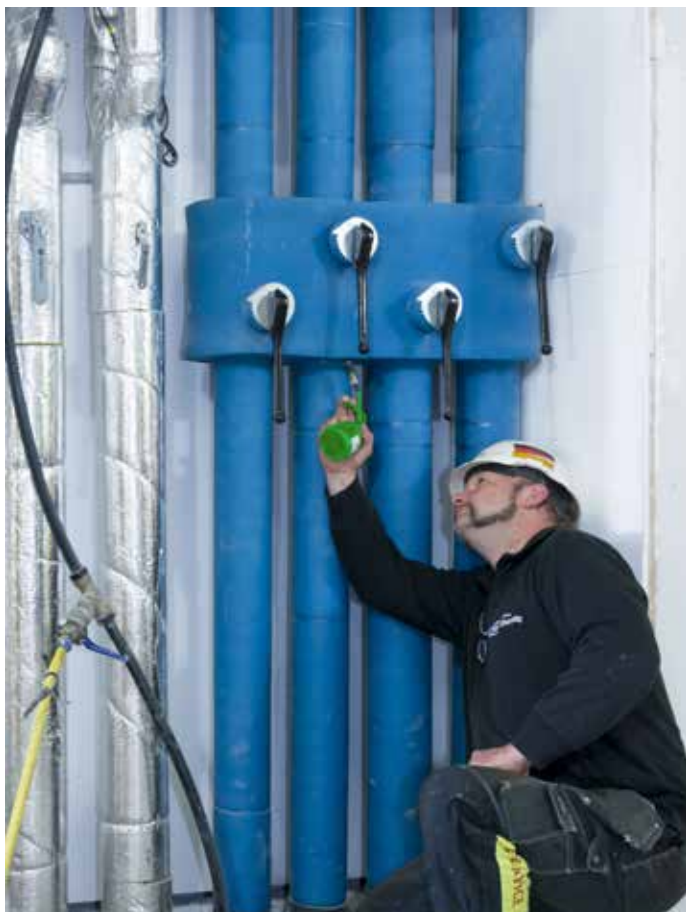
Instalatorzy firmy Knivsta Isolering AB zamontowali ok. 2500 mb otulin Armaflex Ultima oraz około 1000m 2 mat w Skandion Clinic.
