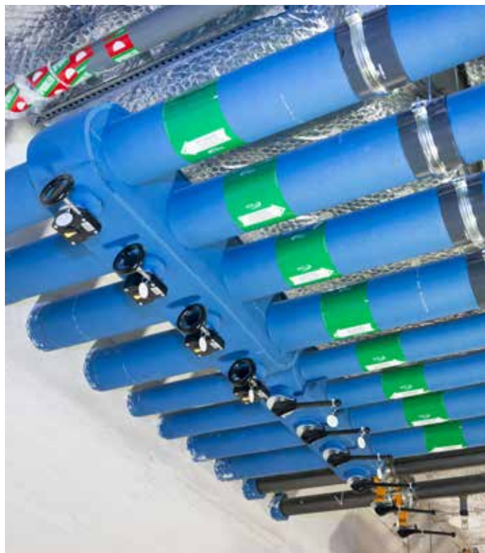
Uchwyty systemowe Armafix Ultima powodują, że rury są osizolowane od obejm stalowych a to zapobiega powstawaniu mostków cieplnych.
