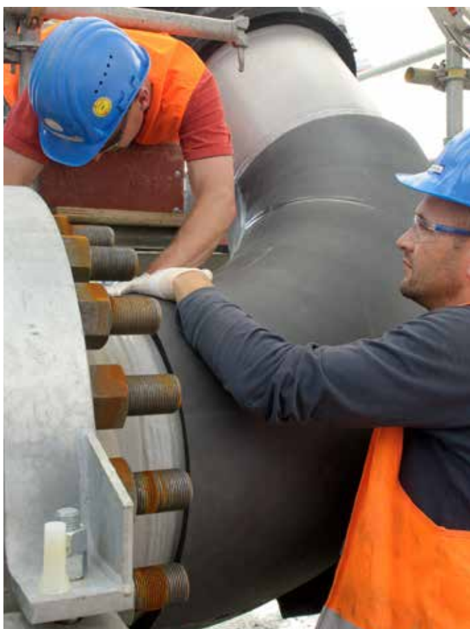
Na kolanack i łukach, Armaflex, ArmaSound RD oraz ArmaSound Barrier wraz ArmaChek R, są cięte w wymagane kształty a następnie instalowane na kolejno po sobie.
