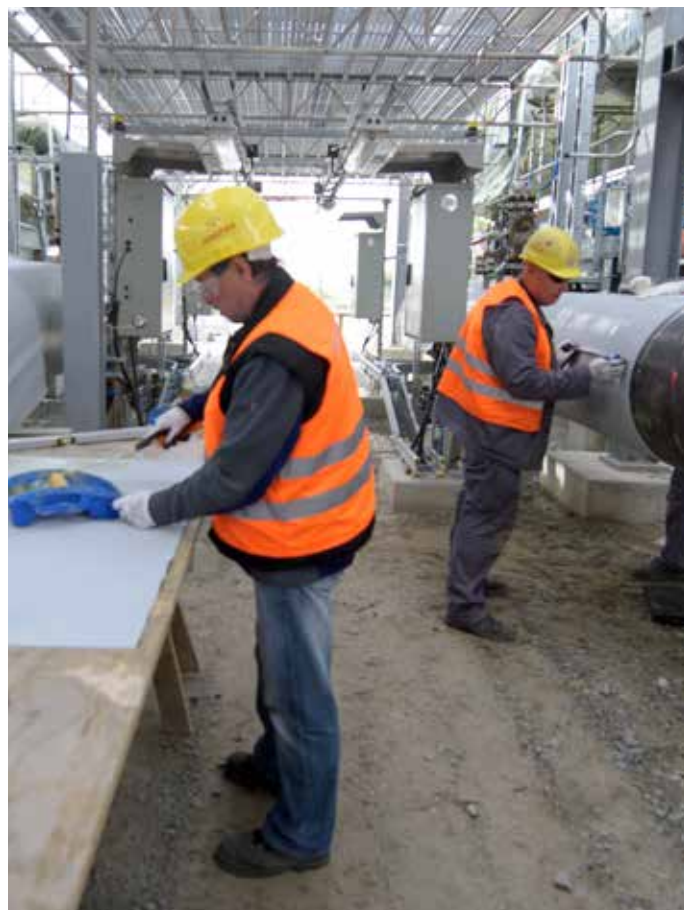
Połączenia czołowe izolacji ArmaSound są trwale i bezpiecznie klejone przy użyciu kleju Armaflex.
