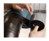
Wrap est simplement enroulé autour du tuyau isolé avec un chevauchement de 20 mm.
