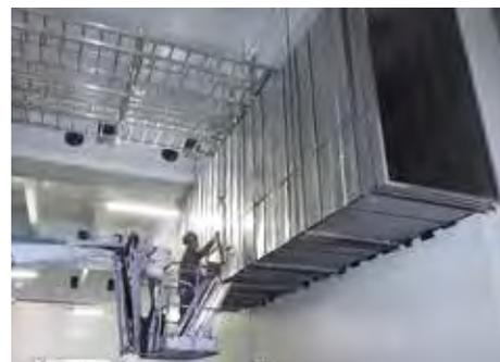
pour isoler l'ensemble des tuyaux et gaines du système de traitement de l'air. En tout, 10 455 m<sup>2</sup> de plaques continues d'Arma-Chek Silver dans des épaisseurs d'isolation de 19, 25 et 32 mm ont été installées.
