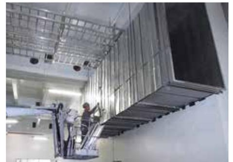
Dämmstoff wurde für die Dämmung des gesamten Rohr- und Kanalsystems der Lüftungsanlage bestimmt. Insgesamt wurden 10.455 m<sup>2</sup> kontinuierliche Arma-Chek Silver Bahnen mit 19, 25 und 32 mm Dicke montiert.
