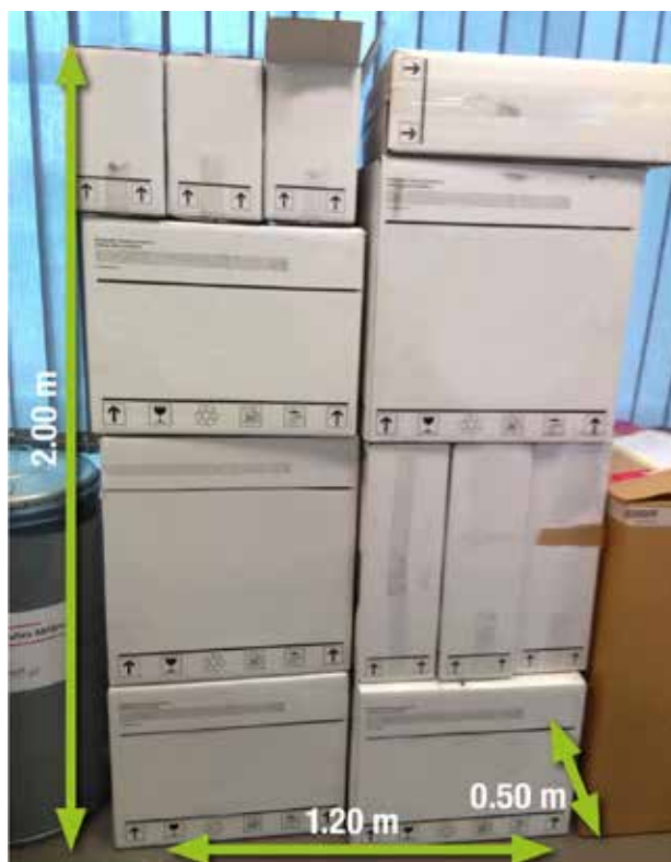
Inte precis utrymmesbesparande: när man använder cellulärt glas måste det finnas tillräckligt med förvaringsutrymme på byggplatsen.
