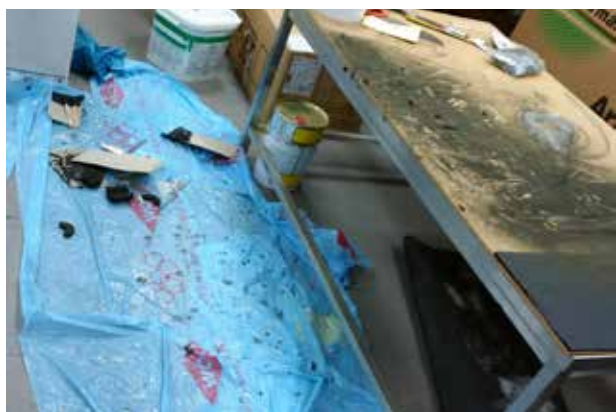
När man installerar PUR och cellulärt glas blir det påtagliga mängder med damm och arbetsområdet ska alltid täckas med en presenning.
