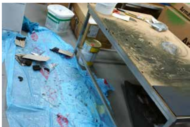
Ved installasjon av PUR og celleglass, ble det generert betydelige mengder støv og arbeidsområdet må alltid være dekket med en presenning.
