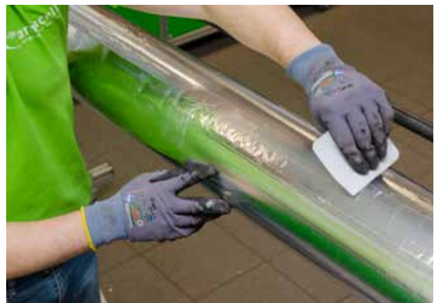
Ook PUR wordt verlijmd met een tweecomponentenlijm. Vervolgens moet een zelfklevende aluminiumtape worden aangebracht op alle lengtenaden en diametervoegen voor een diffusiedichte afdichting.
