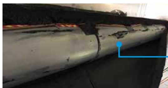
Afbeelding 5: de oppervlakken van de pijpleidingen na het verwijderen van de isolatie (condens)
