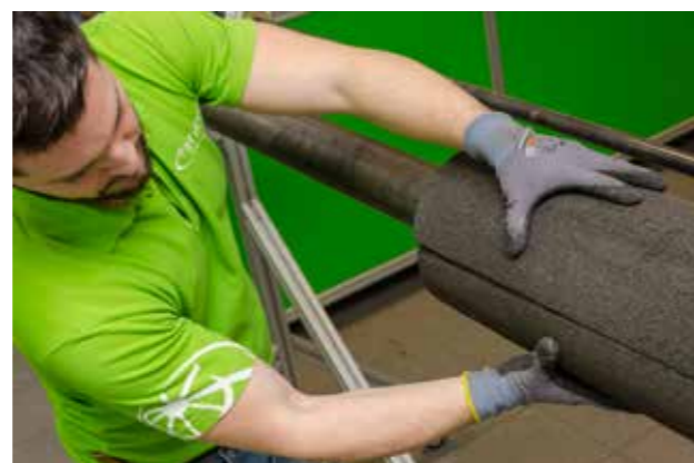
Il vetro cellulare viene installato con un adesivo bicomponente, quindi ulteriormente fissato con nastro di installazione o cinghie metalliche.
