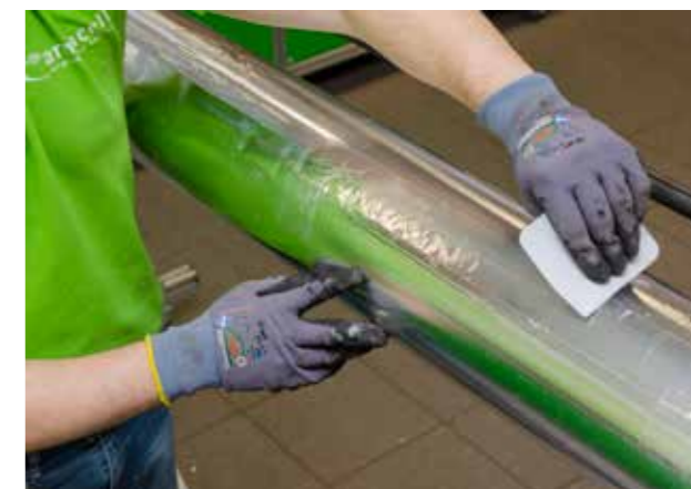
PUR viene anche incollato usando un adesivo bicomponente. Deve quindi essere applicato un nastro adesivo di alluminio su tutti i giunti longitudinali e circolari per creare una tenuta a prova di diffusione.
