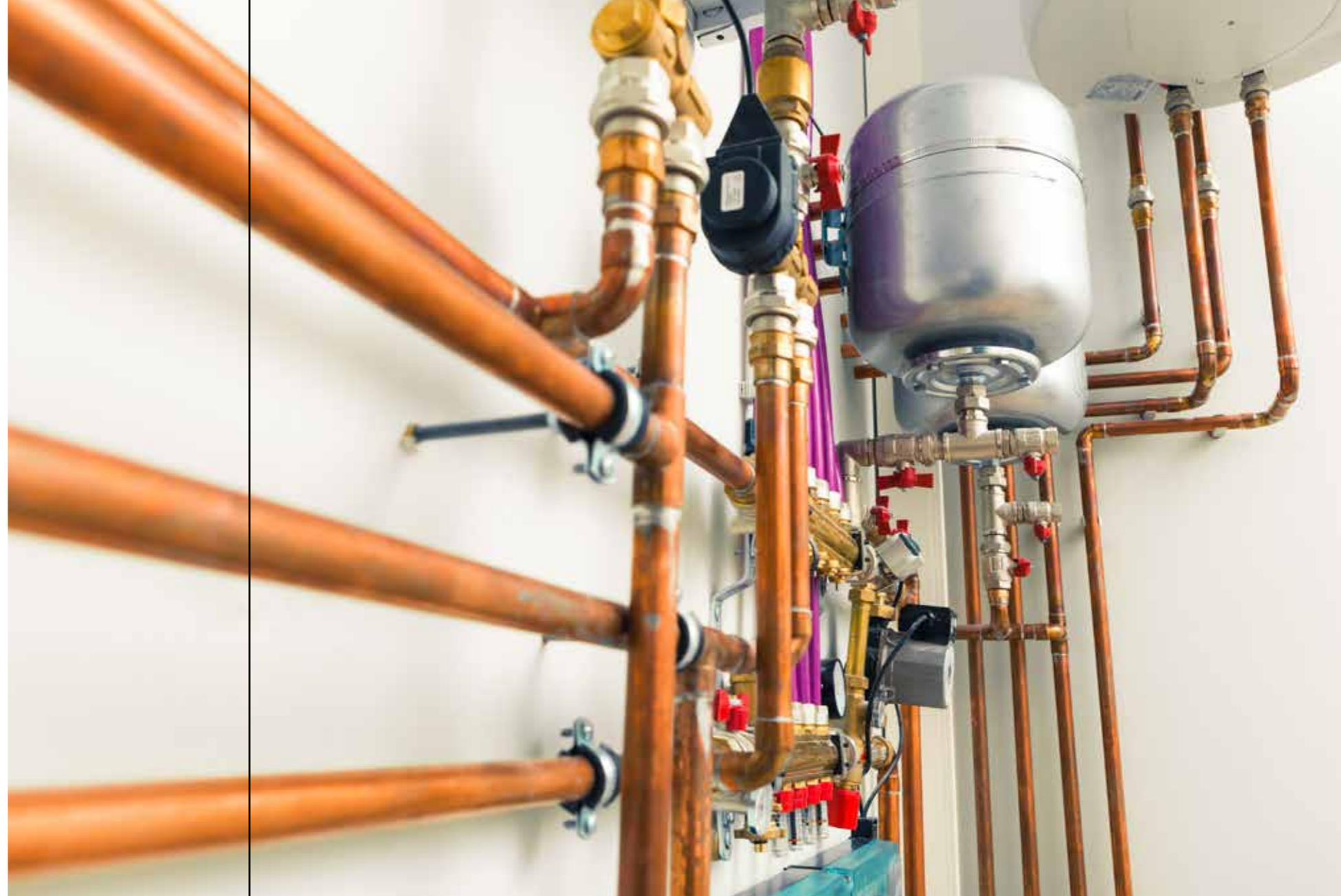
La dispersione di calore dovuta all'assenza di isolamento nelle tubazioni di distribuzione e nei raccordi nei piani interrati può ammontare a un quarto del consumo annuo di energia termica.
