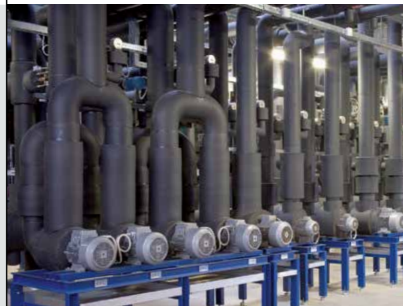
La dispersione di calore dovuta all'assenza di isolamento nelle tubazioni di distribuzione e nei raccordi nei piani interrati può ammontare a un quarto del consumo annuo di energia termica.
