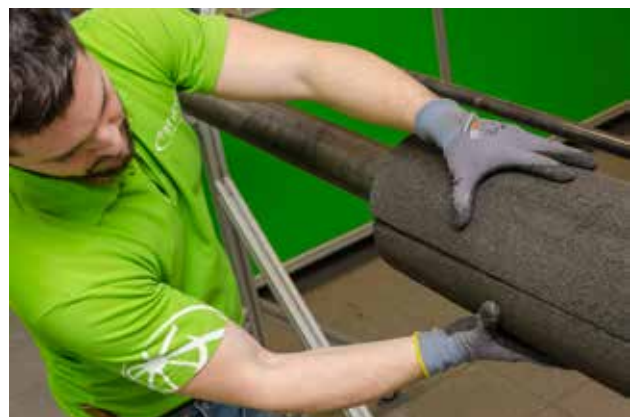
Le verre cellulaire est installé avec une colle à deux composants et sécurisé à l'aide de tige ou de bandes métalliques.
