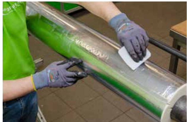
Le PUR est également collé à l'aide d'une colle à deux composants. Ensuite, un tape adhésif en aluminium doit être appliqué sur tous les joints longitudinaux et circonférentiels afin de garantir l'étanchéité à la diffusion.
