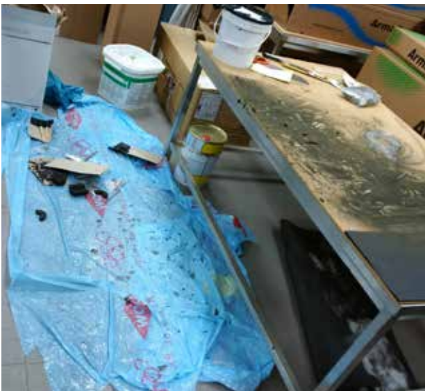
L'installation de PUR et de verre cellulaire entraîne la formation de quantités importantes de poussière et la zone de travail doit toujours être protégée par une bâche.
