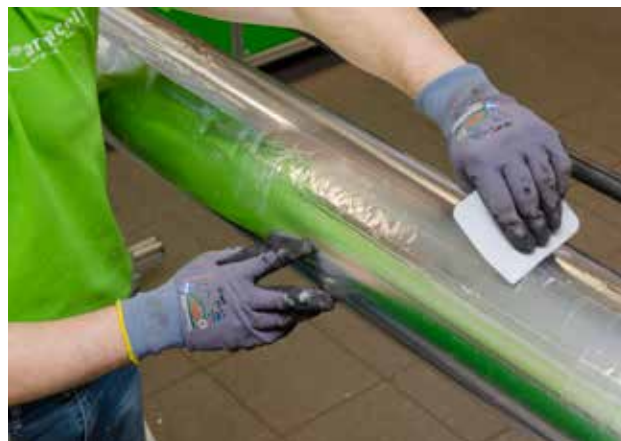
Les mousses PUR sont elles aussi collées à l'aide d'un adhésif à deux composants. Puis un ruban d'aluminium doit être appliqué longitudinalement et sur toute la circonférence afin de créer un joint étanche contre la diffusion.
