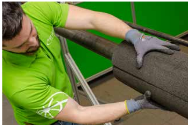
Le verre cellulaire est installé avec un adhésif à deux composants et est ultérieurement renforcé par une bande d'installation ou des bandes métalliques.
