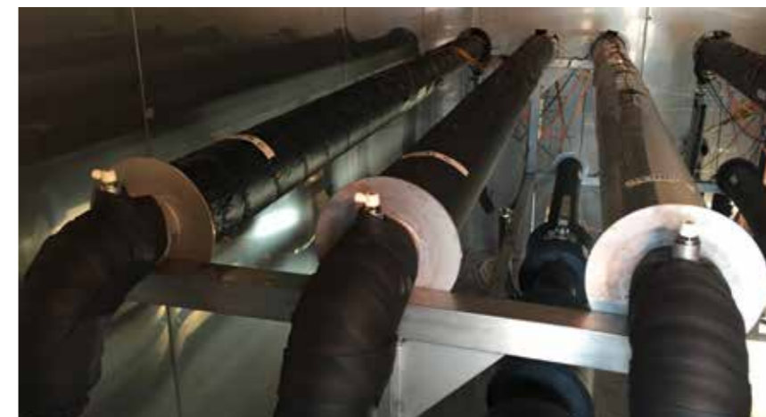
Figure 3 : Mise en place du test : Les échantillons du test endommagés
