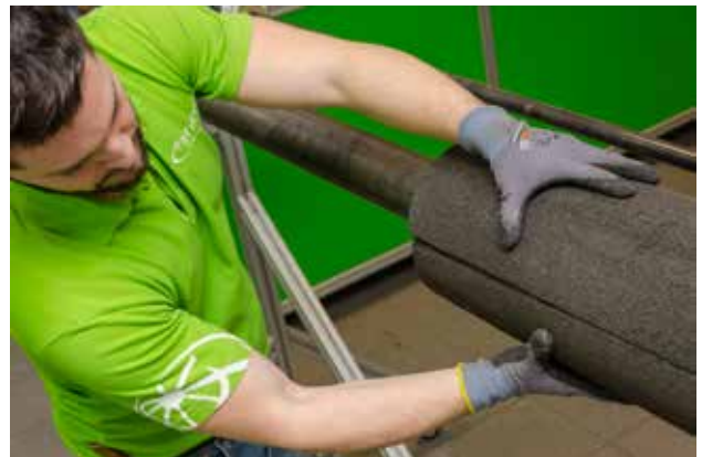
Vaahtolasi asennetaan kaksikomponenttiliiman kanssa ja sen jälkeen se kiinnitetään vielä asennusteipillä tai metallihihnoilla.
