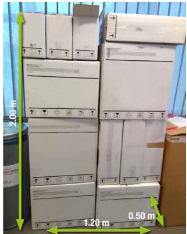
Vaatii runsaasti tilaa: vaahtolasia käytettäessä on työmaalle varattava riittävästi säilytystilaa.
