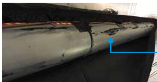
Abbildung 5: Die Oberflächen der Rohrleitungen nach Entnahme der Dämmungen (Tauwasser)
