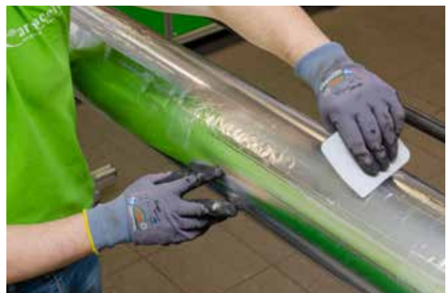
Auch PUR wird mit einem Zweikomponenten-Kleber verarbeitet. Anschließend müssen sämtliche Längs- und Rundnähte mit Aluklebeband diffusionsdicht verklebt werden
