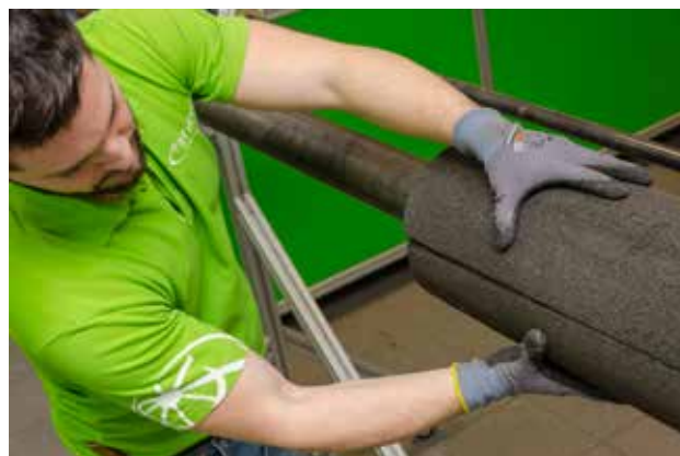
Schaumglas wird mit einem Zweikomponenten-Kleber verarbeitet und zusätzlich mit Montage- oder metallischen Bändern umspannt
