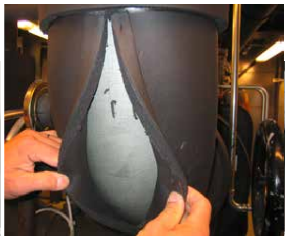
So soll es sein: Mit geeigneten und korrekt ausgelegten Dämmstoffen wird Tauwasserbildung verhindert
