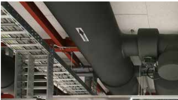
So soll es sein: Mit geeigneten und korrekt ausgelegten Dämmstoffen wird Tauwasserbildung verhindert
