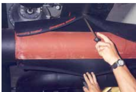
Une des premières installations AF/ArmaFlex toujours en service.
