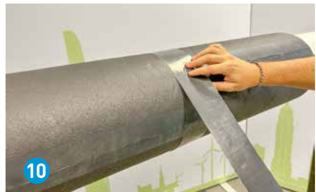
Breng ArmaFlex Ultima C tape aan op de omtreknaden.
