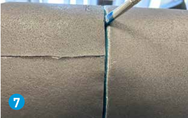
Breng lijm aan op de omtreknaden.
