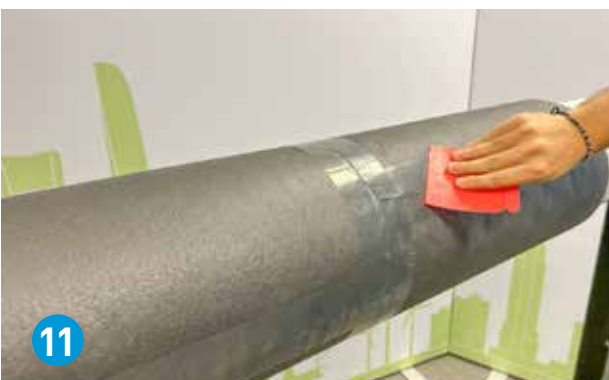
Gebruik een plastic spatel om het oppervlak van de ArmaFlex Ultima C-tape glad te strijken.
