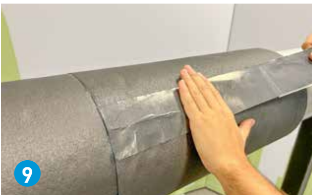
Breng ArmaFlex Ultima C tape aan op de langsnaden.
