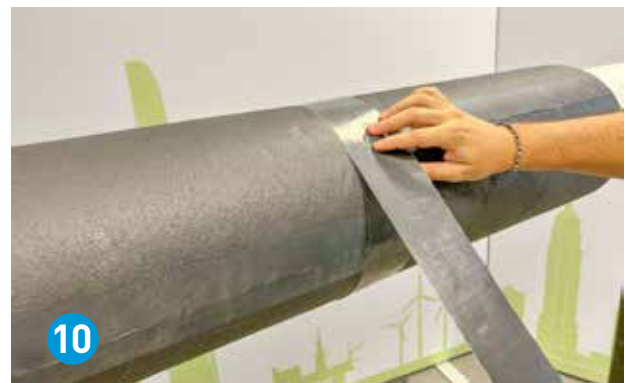
Appliquez le ruban ArmaFlex Ultima C sur les coutures circumférentielles.
