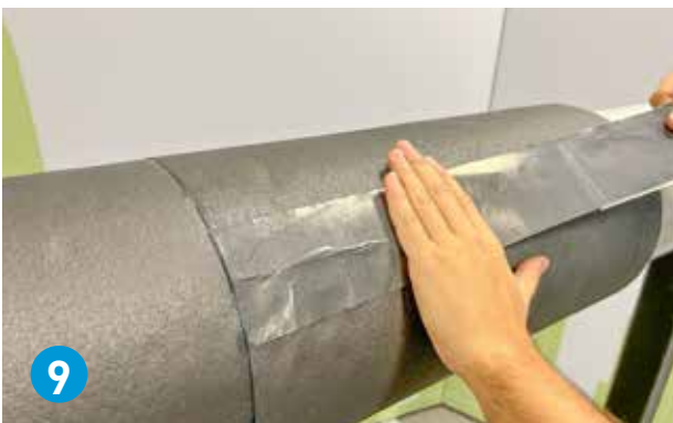
Appliquez le ruban ArmaFlex Ultima C sur les coutures longitudinales.
