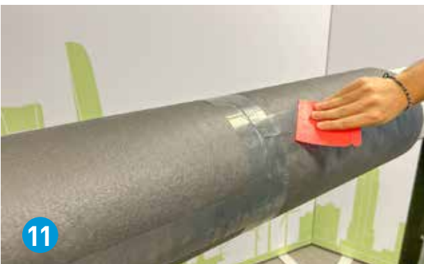
Utilisez une spatule en plastique pour lisser la surface du ruban ArmaFlex Ultima C.
