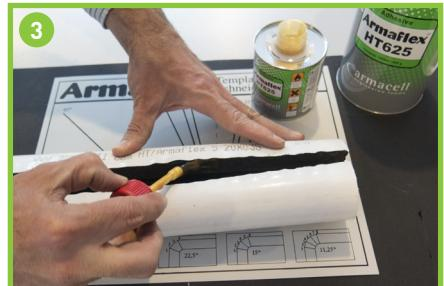
Aplique una película fina y homogénea de Adhesivo Armaflex HT 625 en las dos caras del corte con ayuda de un pincel.
