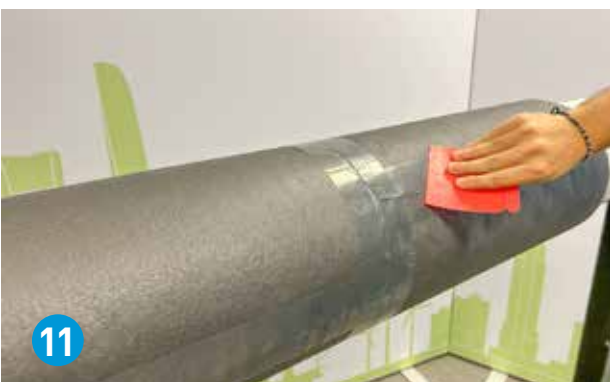
Brug en plastikspatel til at glatte ArmaFlex Ultima C-tapeoverfladen.
