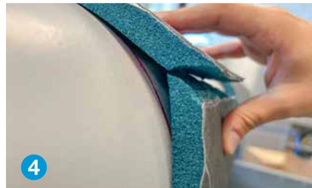
4 Bringen Sie die Isolierung um das Rohr herum an und beurteilen Sie die Umfangspassung.
