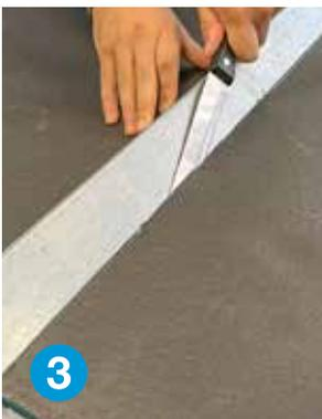
3 Während des Schneidens der Nähte einen 45° schrägen Schnitt mit einer abgewinkelten, geraden Kante machen. Dieses Verfahren ist sowohl bei Längs- als auch bei Umfangsnähten anzuwenden.
