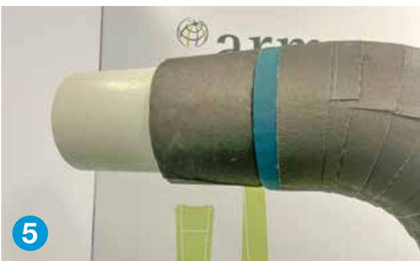
Wenn die 90°-Biegung mit ArmaFlex Ultima erzeugt wird, sollten die Nähte nicht schräg geschnitten werden. Die Stoßfugen des ArmaFlex Ultima C und ArmaFlex Ultima sind miteinander zu verkleben. Die verbleibende ArmaFlex Ultima Fläche ist mit ArmaFlex Ultima C Streifen zu bedecken.
