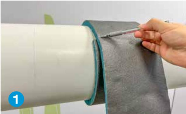
1 Messen Sie den Umfang des Rohres mit einem Streifen ArmaFlex Ultima C.
