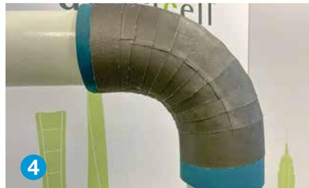
Tragen Sie den Rest der ArmaFlex Ultima C Abdeckteile und den Endstück auf.
