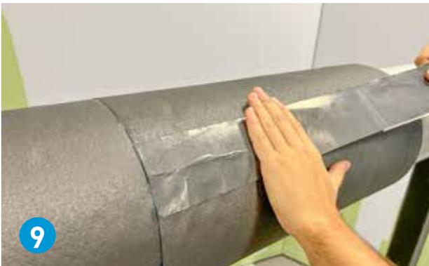
9 ArmaFlex Ultima C Tape auf die Längsnähte auftragen.
