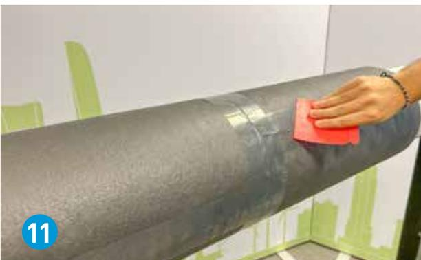
11 Verwenden Sie einen Kunststoffspatel, um die Oberfläche des ArmaFlex Ultima C Klebebandes zu glätten.
