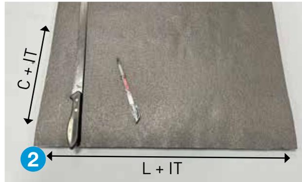
2 Addieren Sie die Dämmstärke (IT) zu den Umfangs- (C) und Längenmessungen (L) und schneiden Sie das gewünschte Teil zu.
