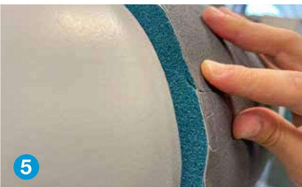
5 Tragen Sie ArmaFlex Ultima 700 Kleber auf die Nähte auf und schließen diese.
