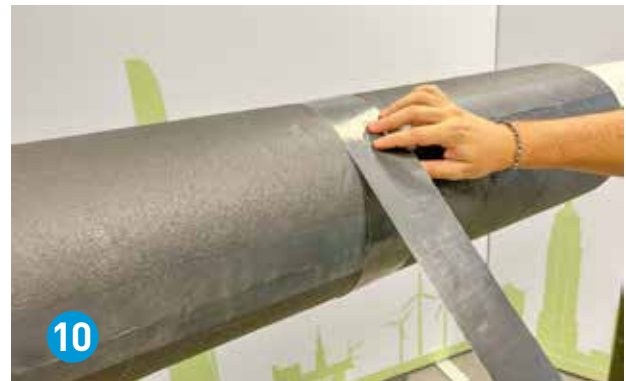
ArmaFlex Ultima C Tape auf die Stoßnähte aufkleben.
