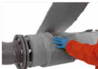
Afbeelding 32: Wikkel het op tot dezelfde dikte als ArmaGel HT op de leiding.
