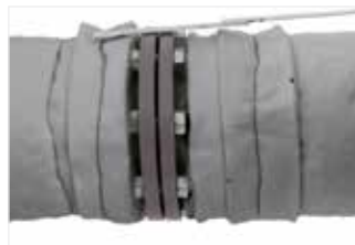
Afbeelding 31: Wikkel 50 mm (2 inch) brede stroken ArmaGel HT om isolatiemateriaal dichtbij de flens aan te brengen (of pas de breedte aan op de totale isolatiedikte indien > 50 mm).
