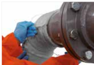
Afbeelding 35: Zorg ervoor dat alle voegen nauw en zonder openingen aansluiten en stevig om de leiding passen, zonder holtes.
