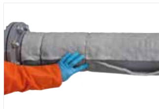
Afbeelding 14: Werk verder aan de naad en sluit hierbij eventuele openingen.
