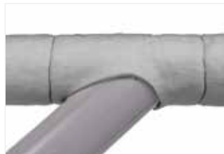
Afbeelding 51: Wikkkel deze om de leiding en zet hem vast met draadband.
