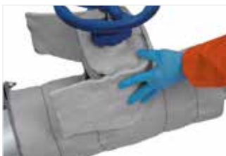
Afbeelding 58: Omwikkel de as van de klep.
