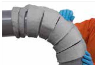
Afbeelding 39: Plaats de uitsnedes aan de binnenkant van de bocht met de lengtenaad naar buiten gericht.
