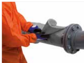
Afbeelding 25: Blijf de leiding omwikkelen om het vereiste aantal lagen te bereiken. Sluit de omwikkeling af met de lengtenaad in lijn met, of overlappend met, het beginpunt binnenin.
