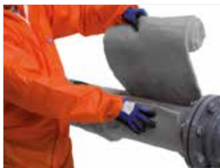
Afbeelding 24: Zorg dat het beginpunt uitgelijnd is met de as van de pijpleiding. Tape of lijm kan nodig zijn om de juiste positie ten opzichte van de as te behouden.
