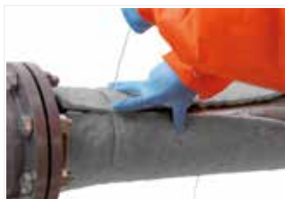
Afbeelding 13: Begin met het aandrukken van de lengtenaad en zet hem vast met draadband.
