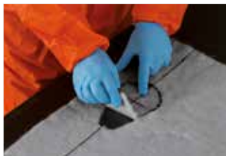
Afbeelding 50: Maak een uitsnede voor de schuine aftakking.
