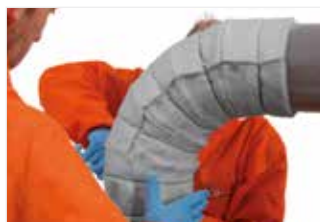
Afbeelding 37: Druk alle sleufen stevig samen om te zorgen dat er geen openingen bij de voegen ontstaan en zet ze vast met draadband.
