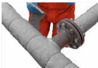
Afbeelding 48: Installeren van het aftakkingstuk.
