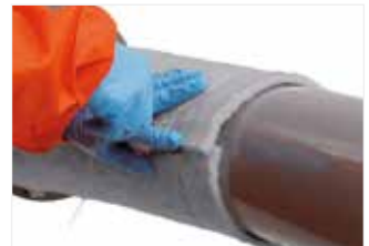
Afbeelding 12: Overlappende lengtenaad.
