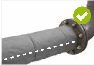
Afbeelding 17: Draai de lengtenaad naar de zijkant.
