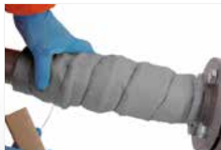
Afbeelding 29: Spiraalvormige omwikkeling met draadband om ArmaGel HT op zijn plaats te houden.
