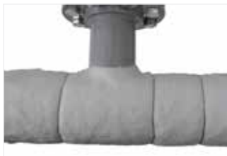
Afbeelding 46: Isoleer de hoofdleiding rond de aftakking.
