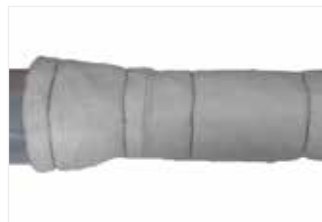
Afbeelding 45: Druk de leidingisolatie stevig tegen het verloopstuk.
