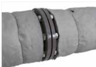
Afbeelding 30: Isoleer dicht op de flens en houd rekening met speelruimte om eventueel bouten te kunnen verwijderen.
