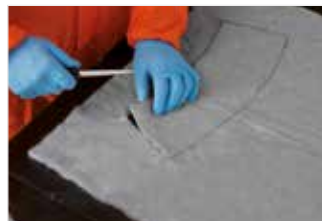
Afbeelding 43: Snijd een radiale strook uit.
