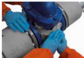
Afbeelding 55: Breng ArmaGel HT rond het kleplichaam aan om holtes te voorkomen.
