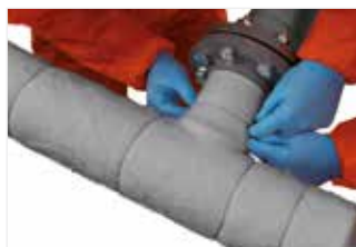
Afbeelding 49: Vastzetten met draadband.
