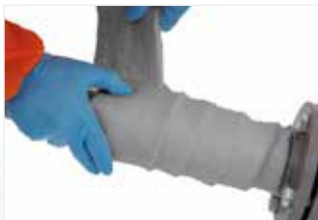
Afbeelding 28: Wikkel 50 of 100 mm brede stroken ArmaGel HT om de leiding. Het materiaal kan nauwsluitend aangebracht worden, of met 50% overlapping.
