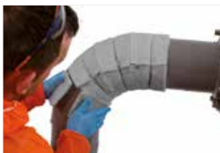
Afbeelding 36: Breng elke sleuf goed op z'n plaats, met genoeg bewegingsvrijheid voor de definitieve aanbrenging.
