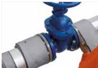
Afbeelding 54: Wikkel stroken ArmaGel HT om de leiding heen totdat de isolatie dikker is dan de buitendiameter van de flens.
