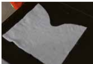
Afbeelding 52: Snijd het materiaal passend om de schuine aftakking.
