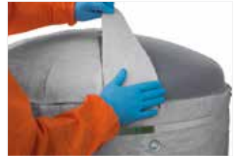
Afbeelding 61: Breng goed tegen elkaar aangedrukte segmenten aan en zet de isolatie vast met stiftpennen en banden.
