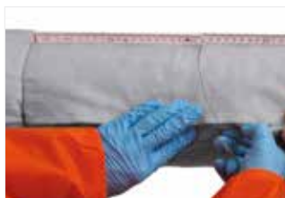
Afbeelding 15: Vastzetten met draadband.
