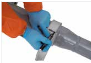
Afbeelding 42: Meet beide omtrekken over de lasnaad.
