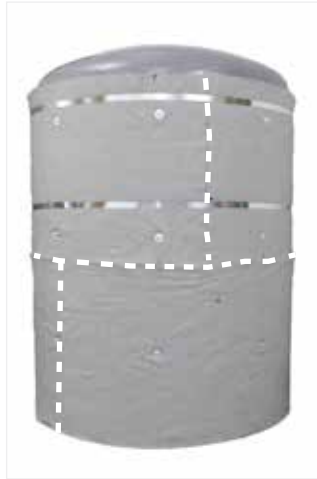
Afbeelding 60: Isoleer vanaf de hoofdflas van het vat. Zet ArmaGel HT platen vast met stiftpennen van de isolatie, laat alle voegen verspringen en bind vervolgens elke laag vast aan het vat.
