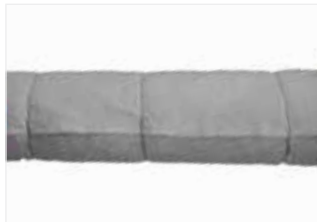
Afbeelding 11: Goed sluitende lengtenaad.
