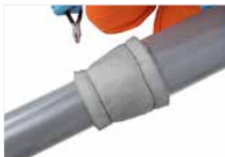
Afbeelding 44: Aanbrenging om het verloopstuk en vastzetten met draadband.
