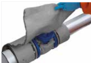
Afbeelding 56: Wikkel ArmaGel HT om de flenzen heen.
