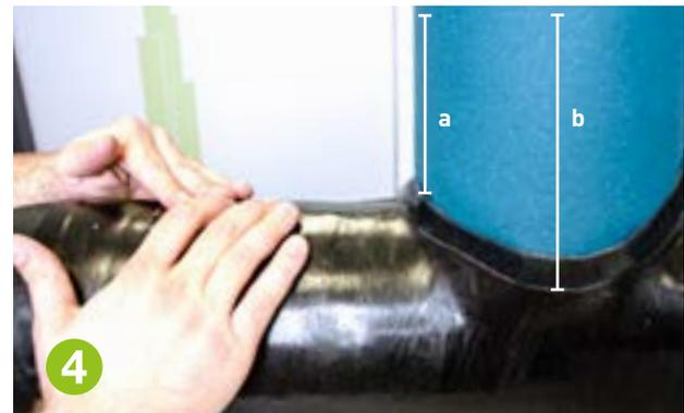
Aplique una presión uniforme en todas las juntas y uniones superpuestas. Verifique que todas las superposiciones estén totalmente fijadas sin dejar separación.
