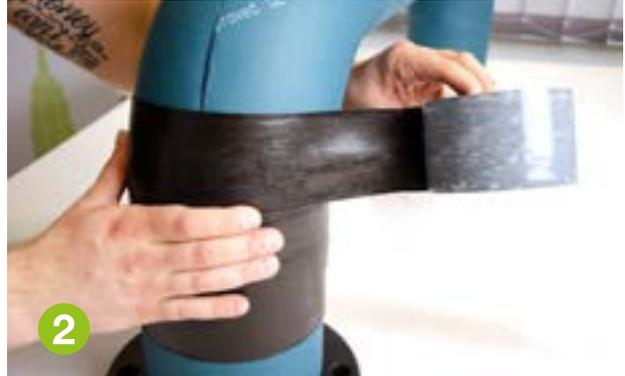
Envuelva el material de recubrimiento autosoldable alrededor de la tubería con aislamiento, asegurándose de que cada nueva capa se superpone a la anterior un mínimo de 20 mm.
