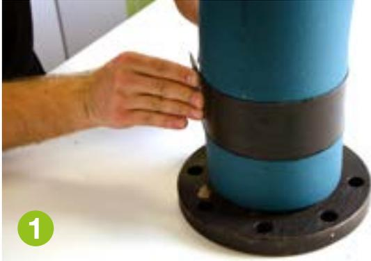
Si el diámetro del codo es superior a 90 mm, puede aplicarse el método de envoltura. Utilice nuestro producto Arma-Chek Wrap con una anchura de 70 mm y comience el proceso de envoltura en un extremo del codo y vaya avanzando hacia el otro extremo.
