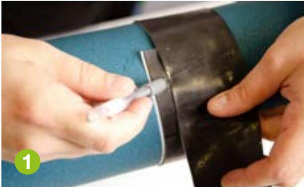
Mida la longitud y el contorno de la tubería que debe recubrirse con nuestro producto Arma-Chek Wrap.
