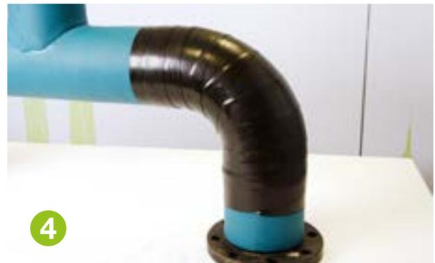
Repita el proceso de envoltura, manteniendo la superposición y la tensión, hasta que alcance el extremo opuesto de la curva.
