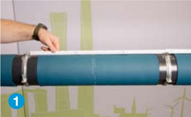
Mida la longitud de la tubería recta entre las dos abrazaderas metálicas ArmaFix.
