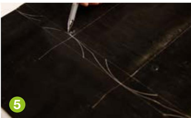
Utilice las longitudes a y b de la imagen anterior para crear el tamaño y la forma de la pieza necesaria y recorte la pieza de conexión.
