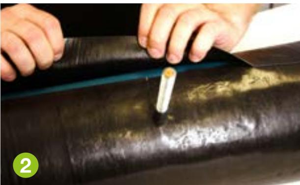
Proceda como si se tratara de un recubrimiento de tubería recta. Incluya un recorte con un diámetro igual al diámetro de la varilla.
