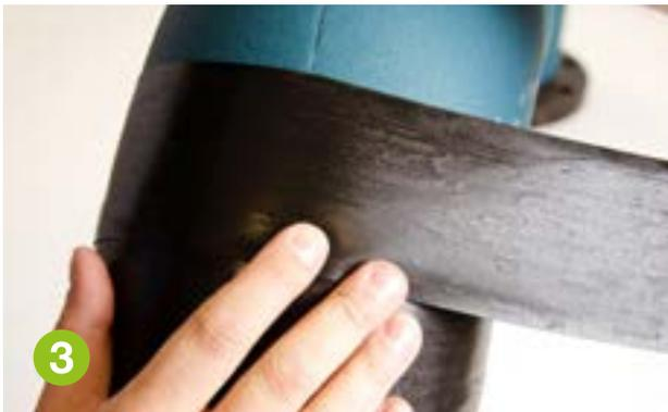
Aplique una tensión moderada al material de recubrimiento autosoldable a medida que va envolviéndolo alrededor de la tubería. Esto contribuye a garantizar una aplicación segura y uniforme.
