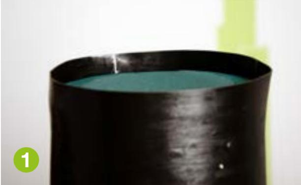
Aplique el aislamiento de la tubería recta como se ha mencionado anteriormente hasta el final de la tubería. Añada 20 mm adicionales de superposición.
