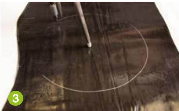
Corte el disco para la tapa con el radio de la tubería aislada y añada 20 mm adicionales.
