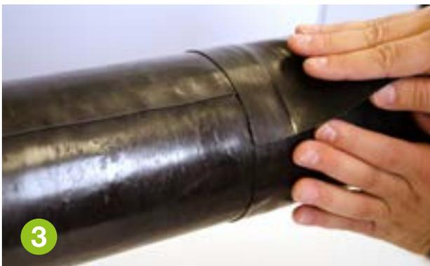
Escalone siempre las superposiciones longitudinales y colóquelas en un lateral con las costuras hacia abajo para crear una barrera impermeable.
