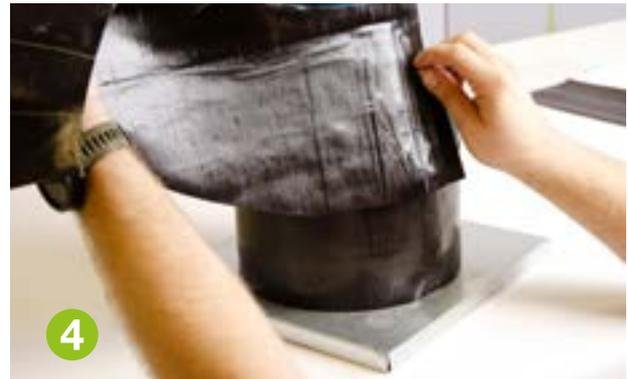
Comience por un extremo del reductor de la tubería y vaya envolviendo con cuidado el material autosoldable alrededor de la tubería. Asegúrese de que el material quede bien sujeto y sin espacios.
