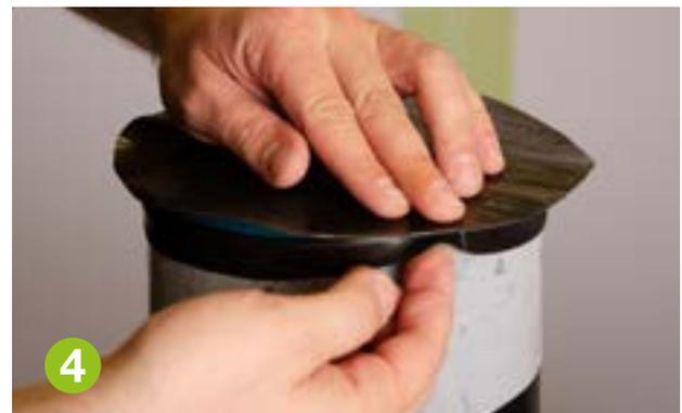
Coloque el disco en el extremo de la tubería y despliegue el primer recubrimiento aplicado. Durante el proceso de vulcanización, es importante hacer coincidir los bordes de la tapa y del recubrimiento de la tubería.
