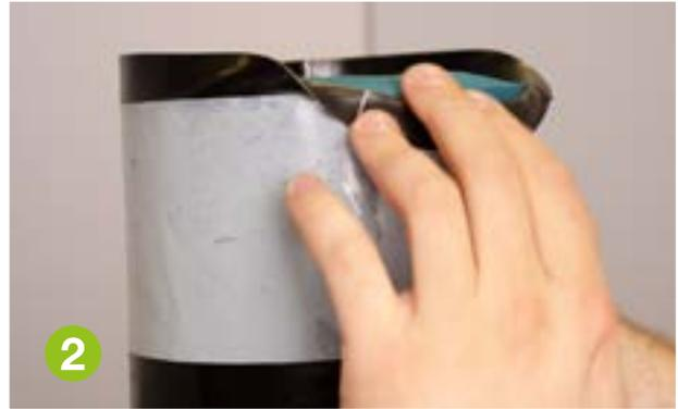
Doble hacia abajo los 20 mm longitudinales adicionales. Para evitar que la sección doblada se adhiera a sí misma, es fundamental insertar un papel antiadherente entre la pieza doblada y la superficie de nuestro producto Arma-Chek Wrap.
