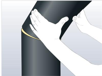
제작된 Armaflex Sheet를 파이프에 감싸주고 절개면에 Armaflex 접착제를 도포하십시오. 접착제가 건조되면 절개면을 접합합니다. 굴절면 연결부도 접착제를 도포하고 접착제가 건조되면 연결부를 접합해 주십시오.
