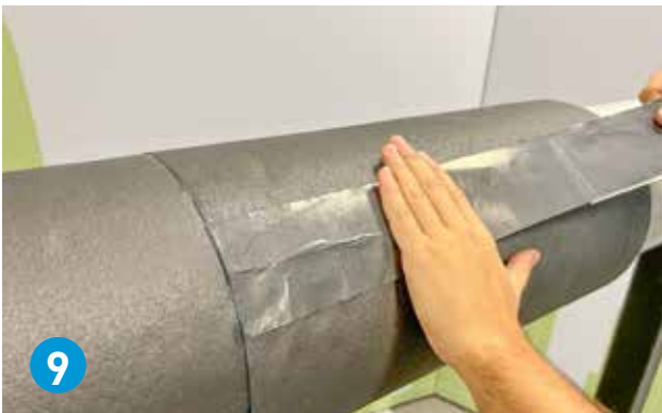
9 Påfør ArmaFlex Ultima C-tape på langsgående skjøter.
